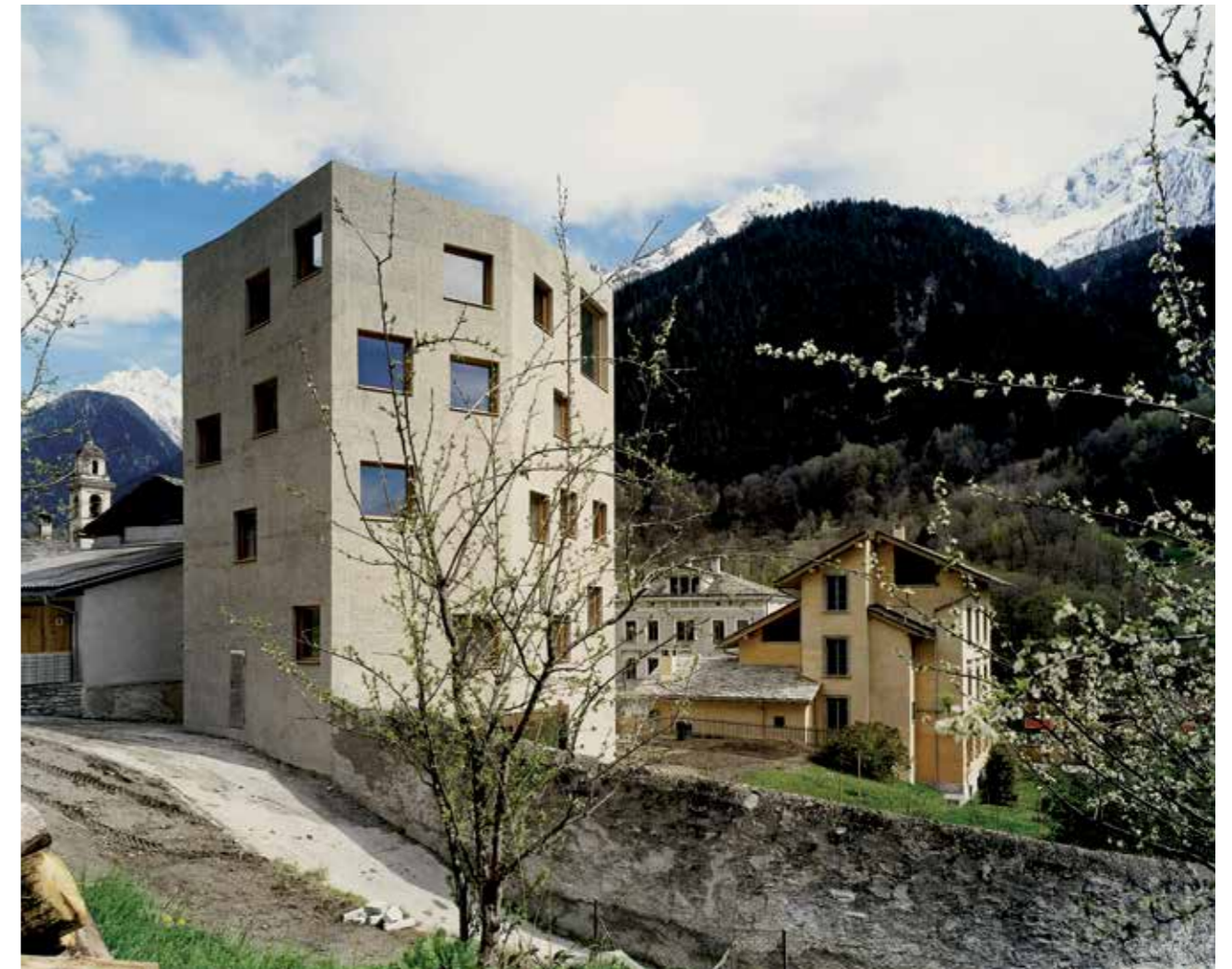
Neubau Roccolo (2004) und Villa Garbald. Foto: Ruedi Walti
